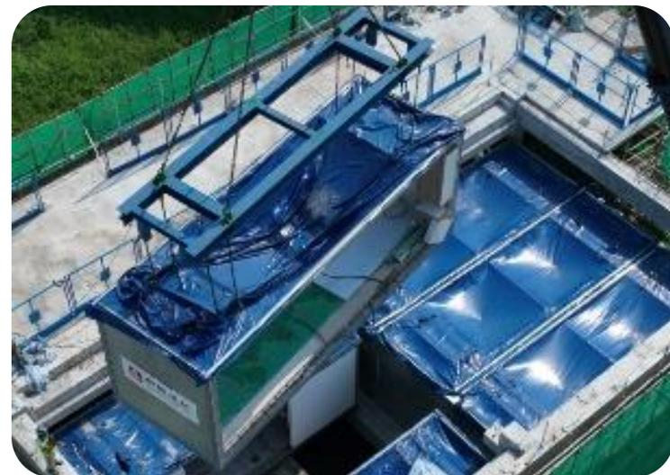
应用MiC及MIMEP 合成建筑法，大大减少现场施工作业，缩短工程时间，降低尘埃及噪音，使得工地现场更干净卫生。同时减少建筑废料的产生，使得项目建设更环保。
