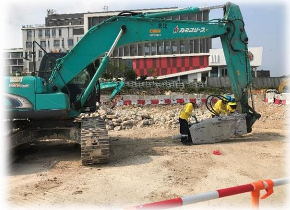
所有炮机使用隔音物料包妥炮头
