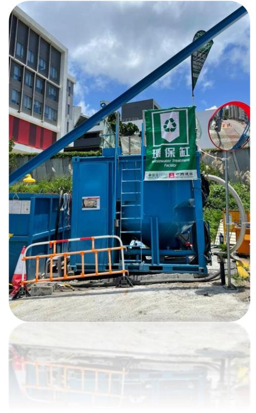
設置三台污水處理設施處理地盤產生的污水。
